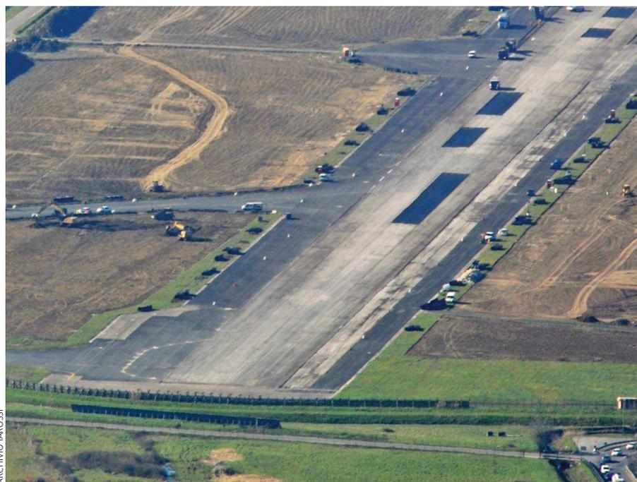
Al momento in cui chiudiamo questo numero sono in corso i lavori di manutenzione della pista esistente 05/23 dell'aeroporto di Firenze. Lo scalo è stato chiuso il 1° febbraio, con riapertura programmata per il 1° aprile. Sono previsti interventi di rifacimento della pavimentazione della pista, delle strip di sicurezza, della segnaletica orizzontale e dei dispositivi luminosi.
