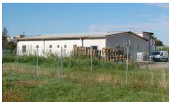
Figura 31 - Edificio Catering Aviazione Commerciale
