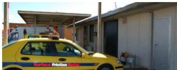
Figura 28 - Edificio Ex Alitalia Magazzino AdF
