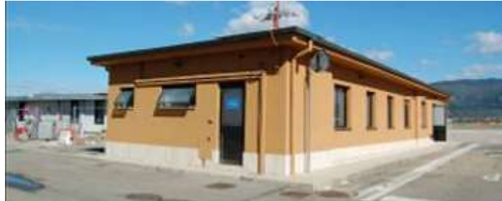
Figura 21 – Edificio ex Meteo
