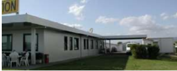
Figura 32 - Edificio Aviazione Generale
