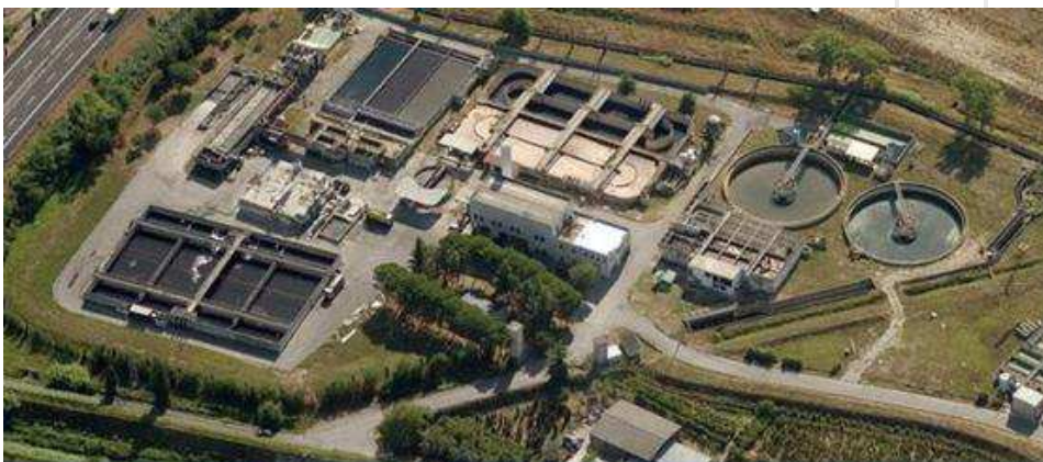
L'impianto de depurazione di Gida al Bagnacavallo
